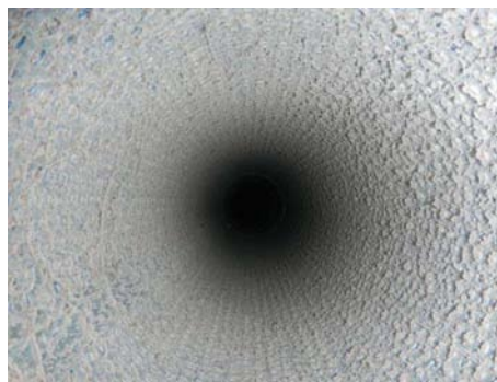
Poistoilmapiiput ovat likaisia.
