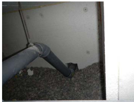
Yleiskuva alapohjan viemäriasennuksista.
