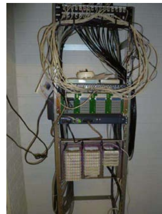
Puhelintilan irrallinen palovaroitin
