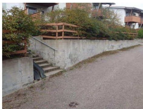
Kuvassa vaunujen kulkusillat vaurioituneet
